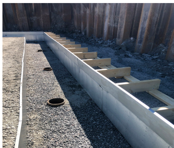
Kantform med förhöjningslist - flexibel höjdjustering på plats
