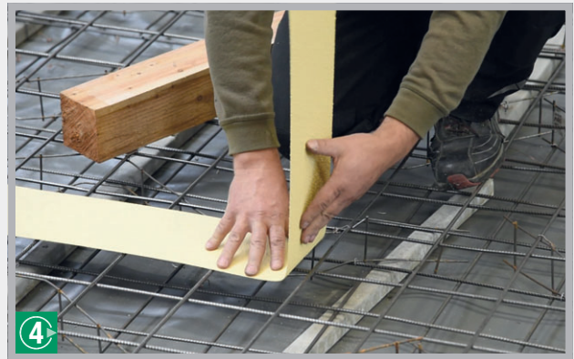
4 Enkel bøying av platen uten brister
