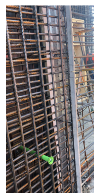
Väggevstängare 7F, FB med betongdistans innan gjutning
