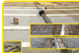
Exempel på K-Form monterat på et 150 mm tjock betonggolv
