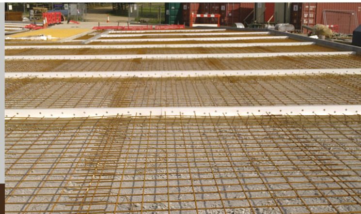
Exempel på K-Form monterat på et 150 mm tjock betonggolv
