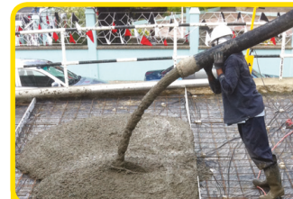
K-Form förblir på plats efter gjutning
